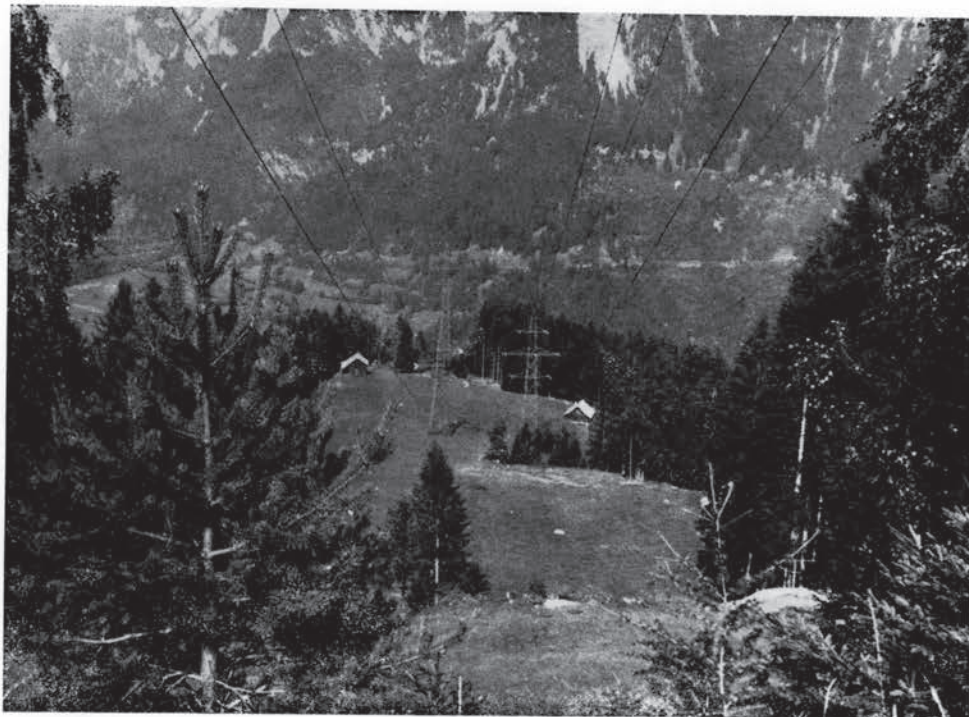
Fig. 49 - Situazione delle rocce I e II, con una vista sulla Valle Domigliasca.
